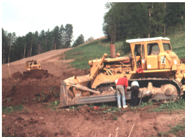
Travaux de terrassement pour une piste de ski (74)
